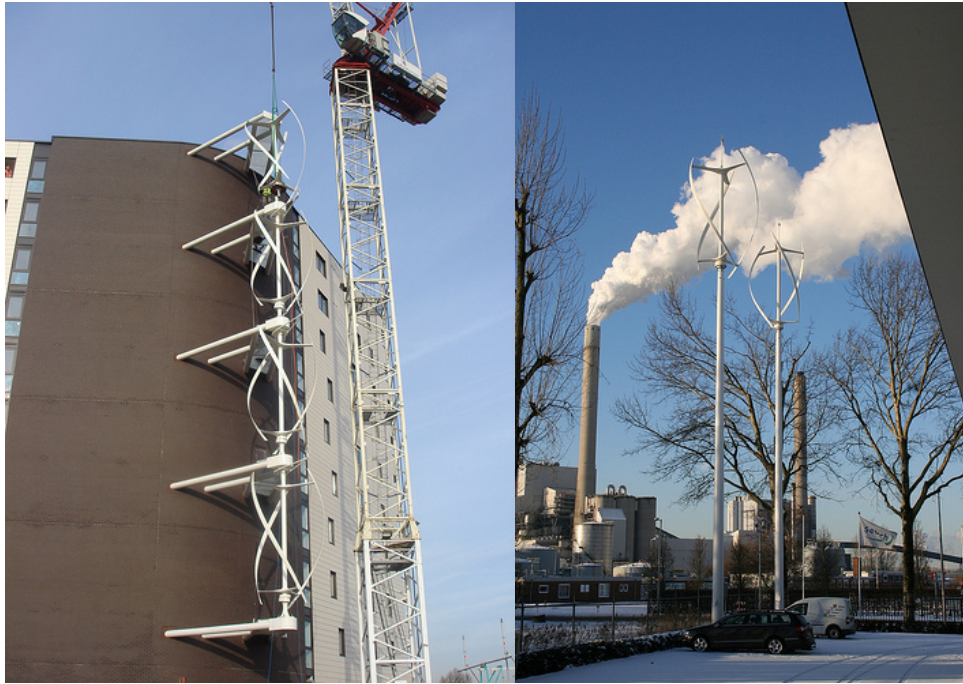
Slika 10: Postavljanje vjetroturbina na vertikalnoj osi na fabričkim postrojenjima
